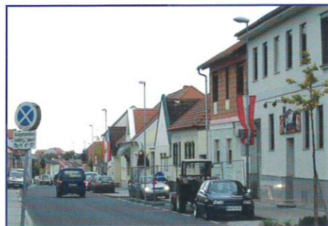
Vorerst wird die Straßenbeleuchtung in der Landesstraße saniert.
