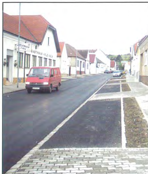
Die Arbeitergasse und die Hauptstraße sind mit einer neuen Asphalttschicht versehen. Der Mühlweg wird dzt. ausgebaut.
