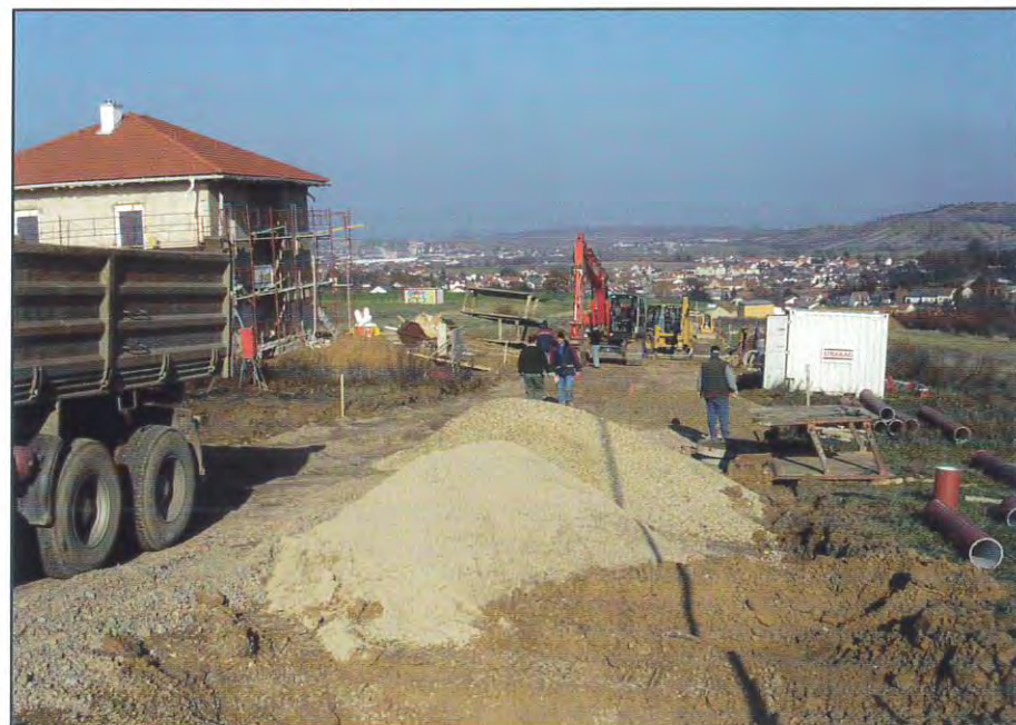
Neues Bauland wird derzeit im Ried "Steindlacker" aufgeschlossen. Der neue Kanalstrang wird durch das Grundstück des Arbeiterhilfsvereines in den bestehenden Kanal in der Berggasse einmünden.
