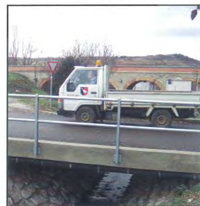
Die Brücke über den Ödenmühlbach wurde neu errichtet. Die Brücke über den Ortsbach wurde saniert und mit einem neuen Geländer versehen.
