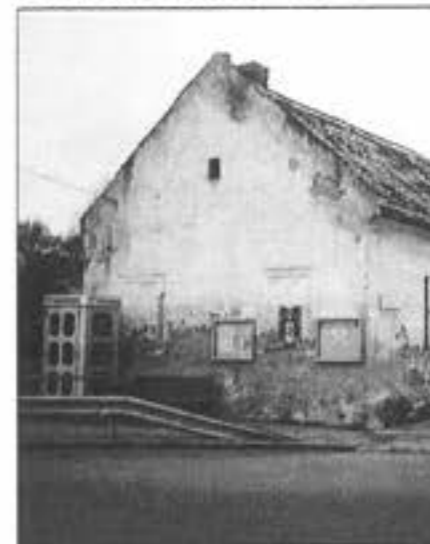
Als erstes Objekt soll der linke Teil abgerissen werden
