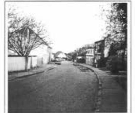
So sah ein Teil der Bachgasse vor Beginn der Arbeiten aus
