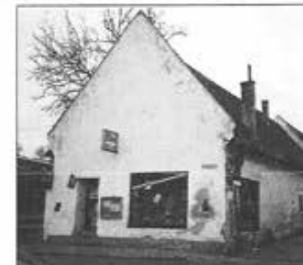
Nach Vollendung der 1. Ausbaustufe wird der rechte Teil abgerissen
